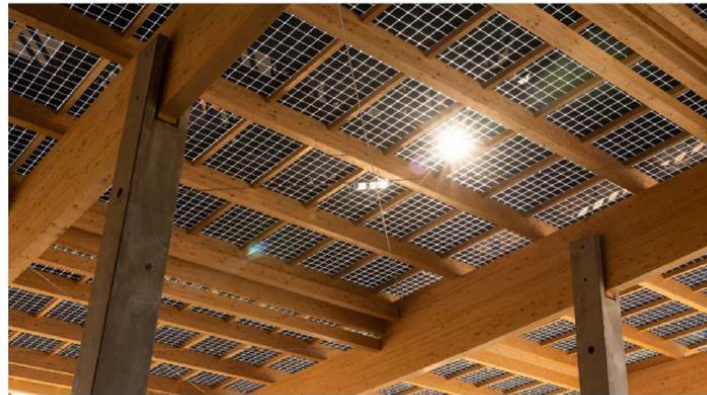
Sonnekraft solar shed roof Solarstrasse 1, 9300 St. Veit an der Glan, Austria Fonte: SONNENKRAFT GmbH
